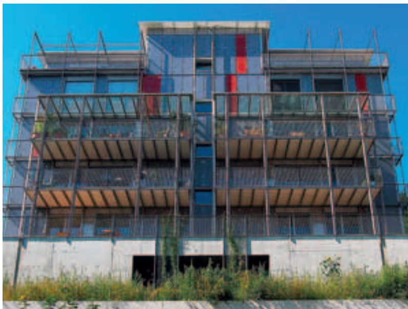
In der Frontalansicht: Das erste Minergie-P-Mehrfamilienhaus in Winterthur. Die Balkone sind freistehend angeordnet. Alle Fotos: G. Wolf
