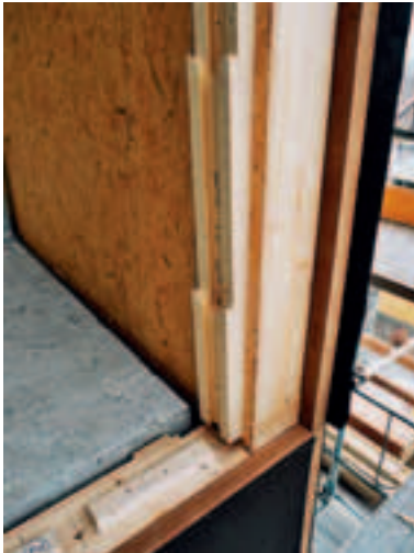
Eckanschluss (System «Rutz») der Holzrahmenbauelemente (links). – Gewährte Ansicht einer Wohnraumsituation (rechts).
