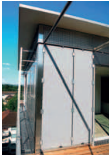
Auch im Dachgeschoss (Eckdetail) prägt die Vorstruktur aus Chromstahl und Glas das Fassadenbild.
