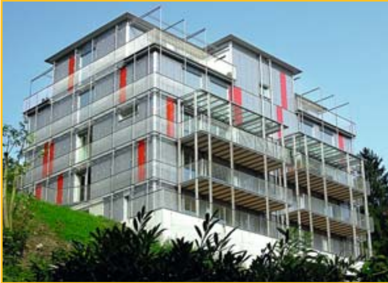
Zur Langgasse hin sind die Balkone freistehend, das heisst ohne Durchdringung der Wärmedämmung, angeordnet. Rund um das Gebäude ist eine Vorstruktur in Chromstahl angebracht. Diese soll möglichst rasch begrünt werden, dient aber auch dem Unterhalt der Fassadengläser
