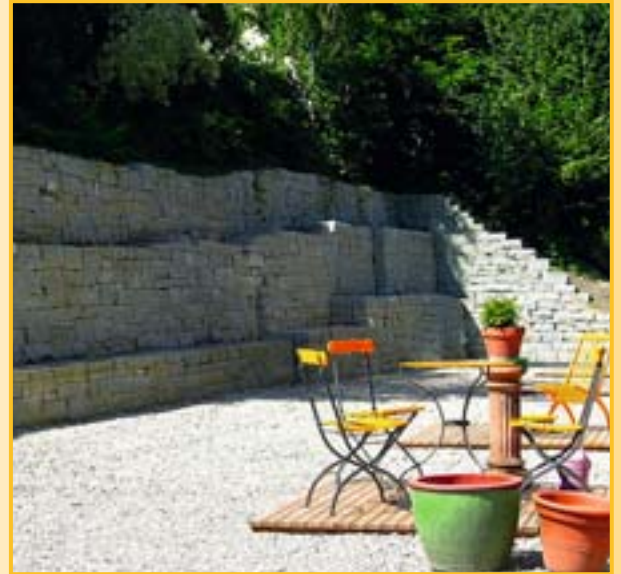
Die hangseitige Situation wurde mit einem Sandstein-Trockenmauerwerk gesichert. Ideale Bedingung für Pflanzen und Lebewesen
